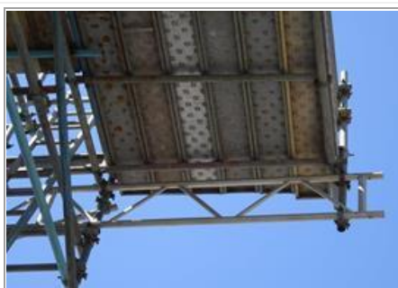
Voorbeeld van een vrijdragende (uitbouw) steiger
