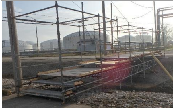
Steigerbrug met 7,5 m afstand tussen de verticale steunen
