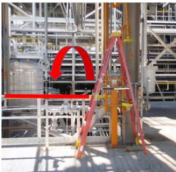
Een werknemer op deze trapladder loopt het risico om over de top van het reling te vallen.
