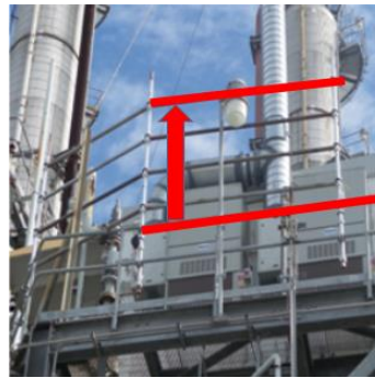
Een voorbeeld van een verhoogde reling van steigerdelen die gebruikt wordt om reling te verhogen.
