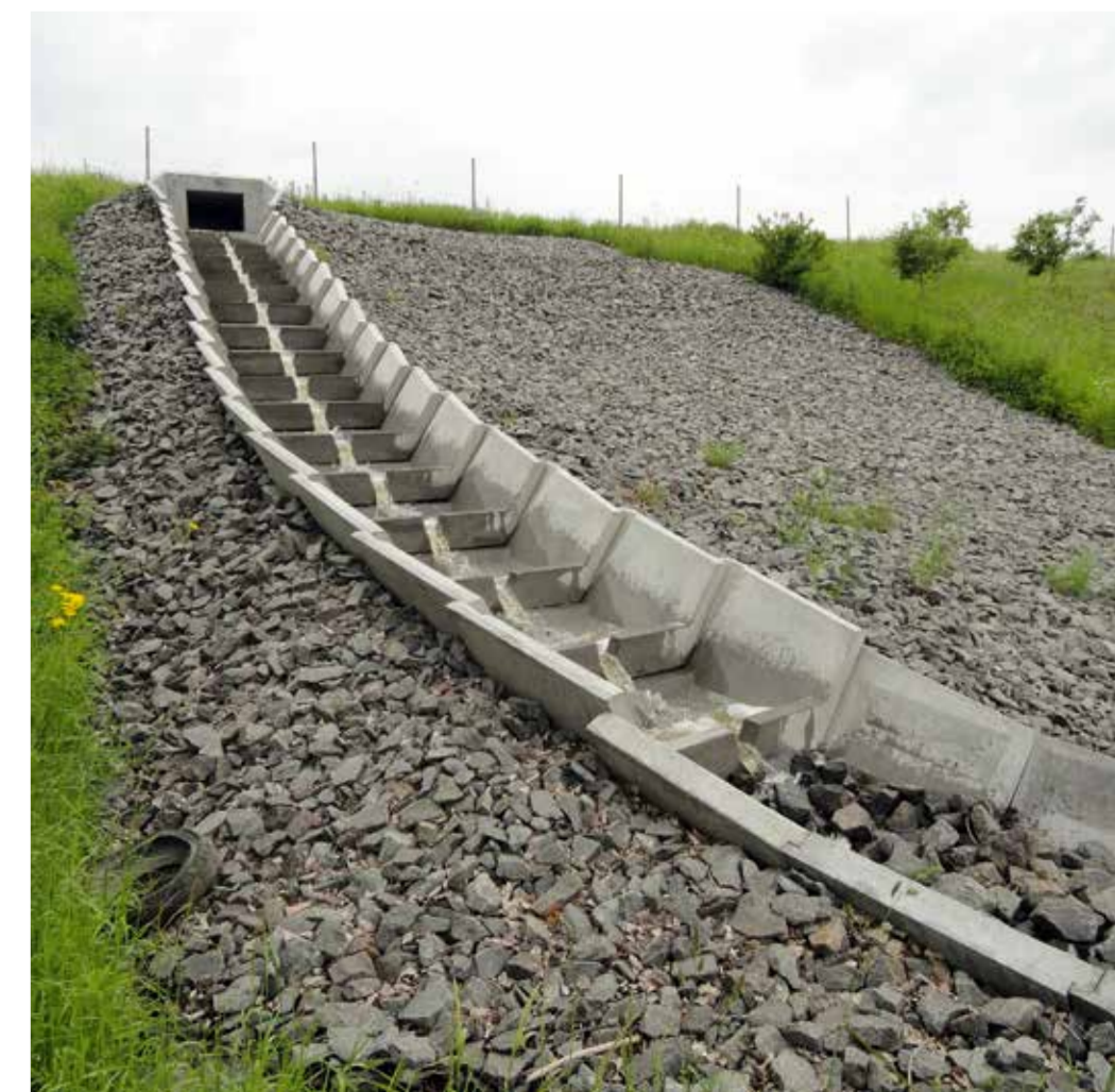
Die „Alten Auflandbecken“ in Gaulis sind erfolgreich abgedeckt.
