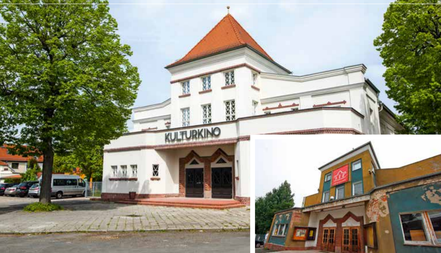
13 Jahren dauerte die Sanierung des Kulturkinos Zwenkau. Neben der Bereitstellung von Spenden legten Dow-Mitarbeiter selbst Hand an.
