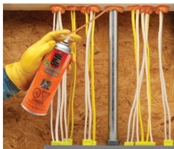
Pénétrations électriques au plancher
