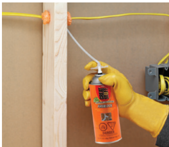
Pénétrations électriques à travers les montants
